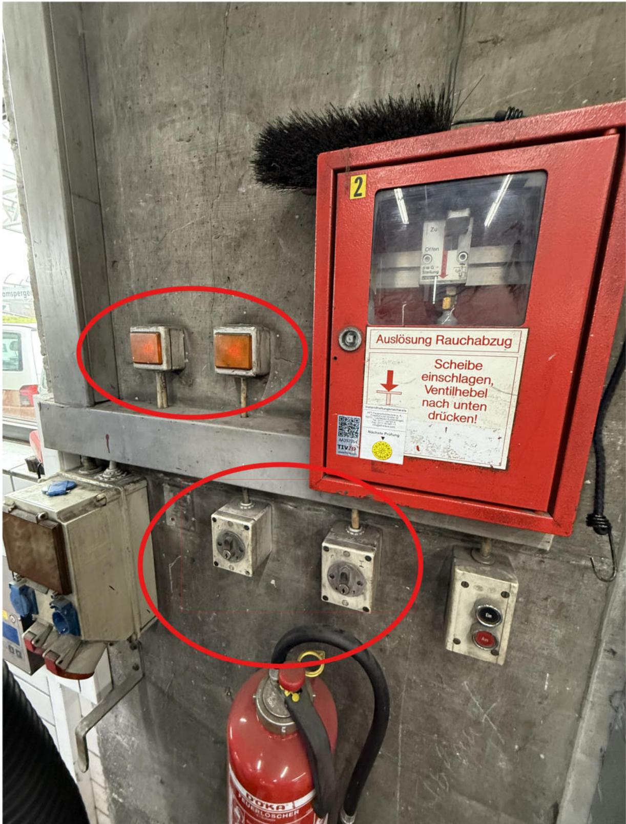
Hauptstrom und Tore mit Schlüssel 7 Ein-Ausschalten. Wenn die oberen Kotrollen orange leuchten ist der Strom und die Tore aktiv!
